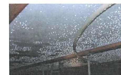
断熱材表面に付着した多量の結露
