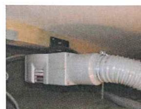
ダブルシャーターは大引等にネジで吊下げ設置するだけなので、工事は非常に簡単です。本体下面のパネルから吸い込まれた空気は、ダクトから外部へ排出されますが、本機はさらに周囲4方向への攪拌送風をおこないます。
